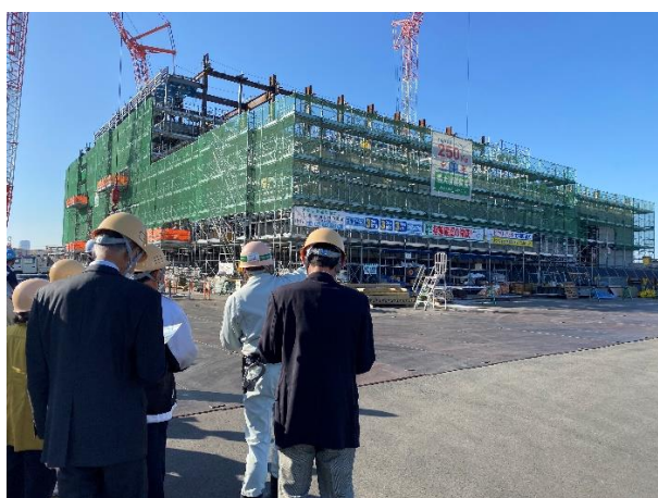
① 新焼却施設建設工事現場(真木町)
